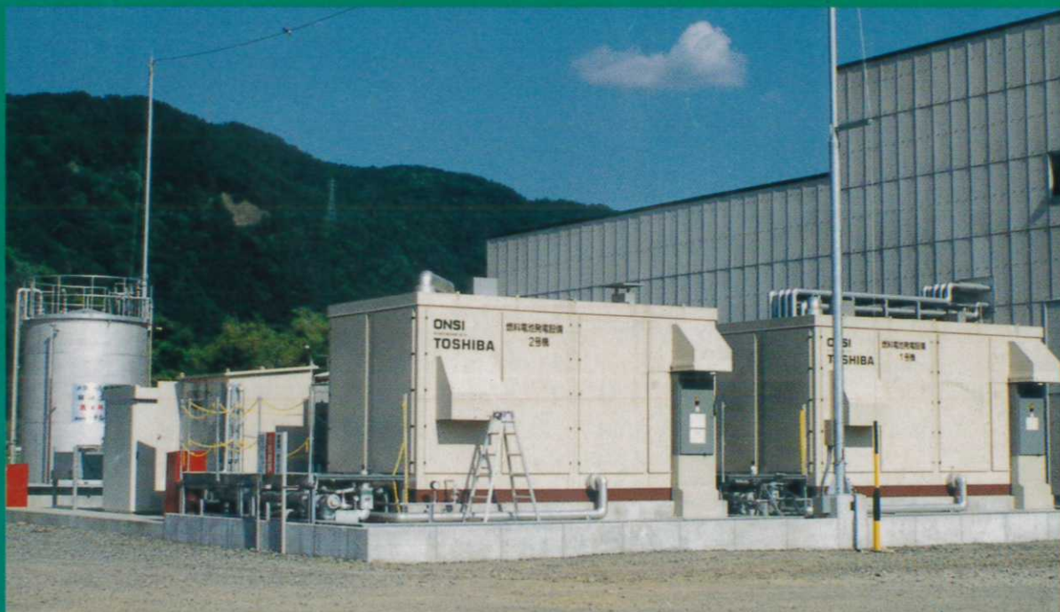
工業廃棄物のメタノールを燃料にした燃料電池(セイコーエプソン株豊科事業所設置:特集記事参照):東芝製
